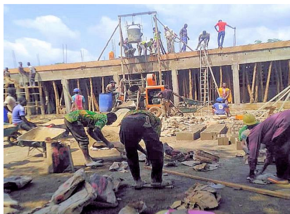
Schulgebäude 2 mit Lehrerzimmer und Büro
