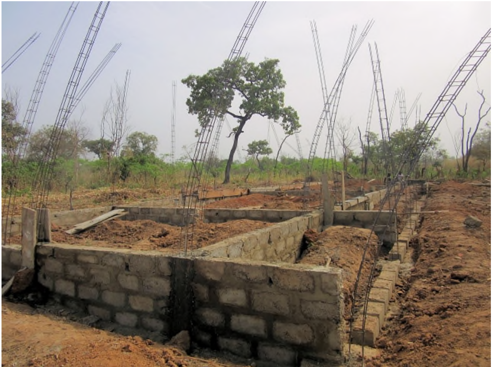
Anlagen der Fundamente und senkrechten Träger
