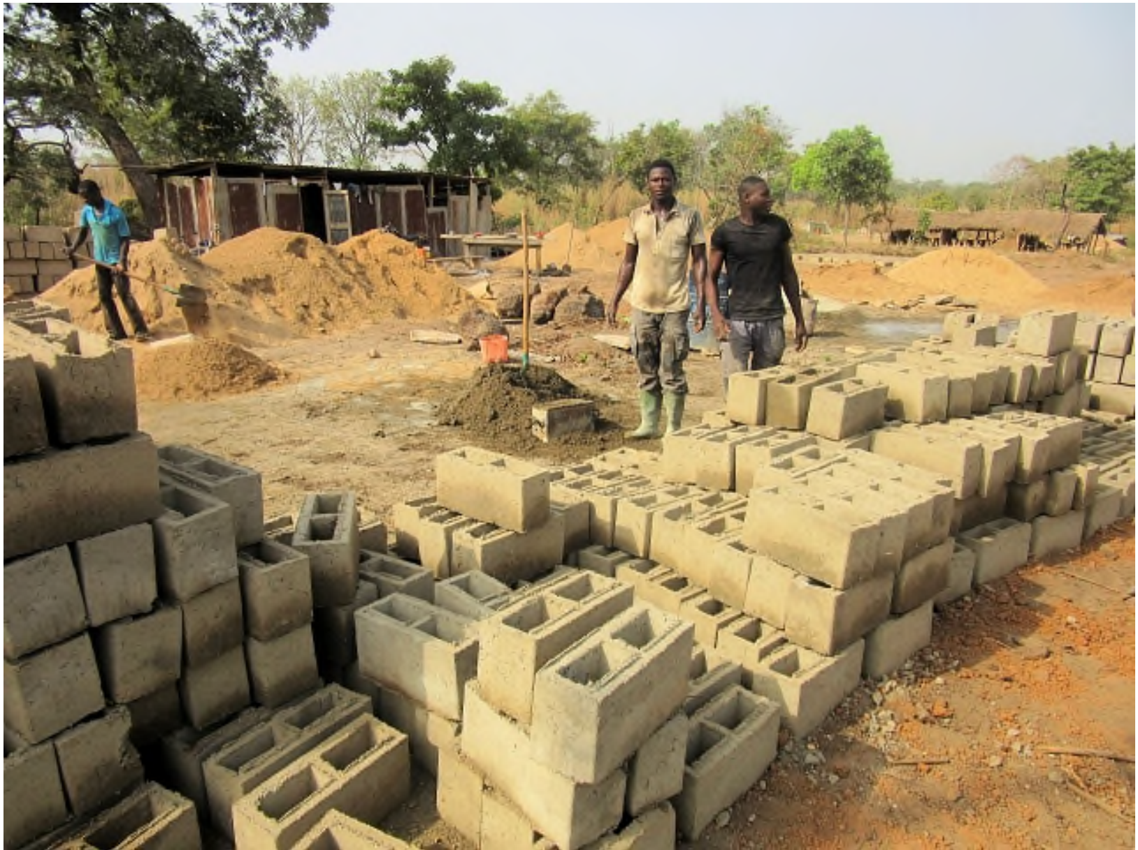
Mit Eisenformen werden Betonsteine gegossen
