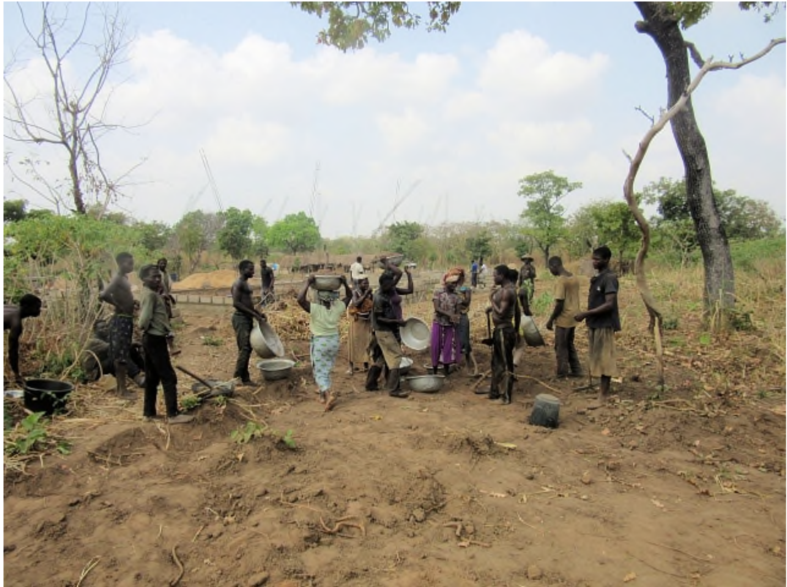
Die Dorfbewohner helfen mit und unterstützen die Bauarbeiter
