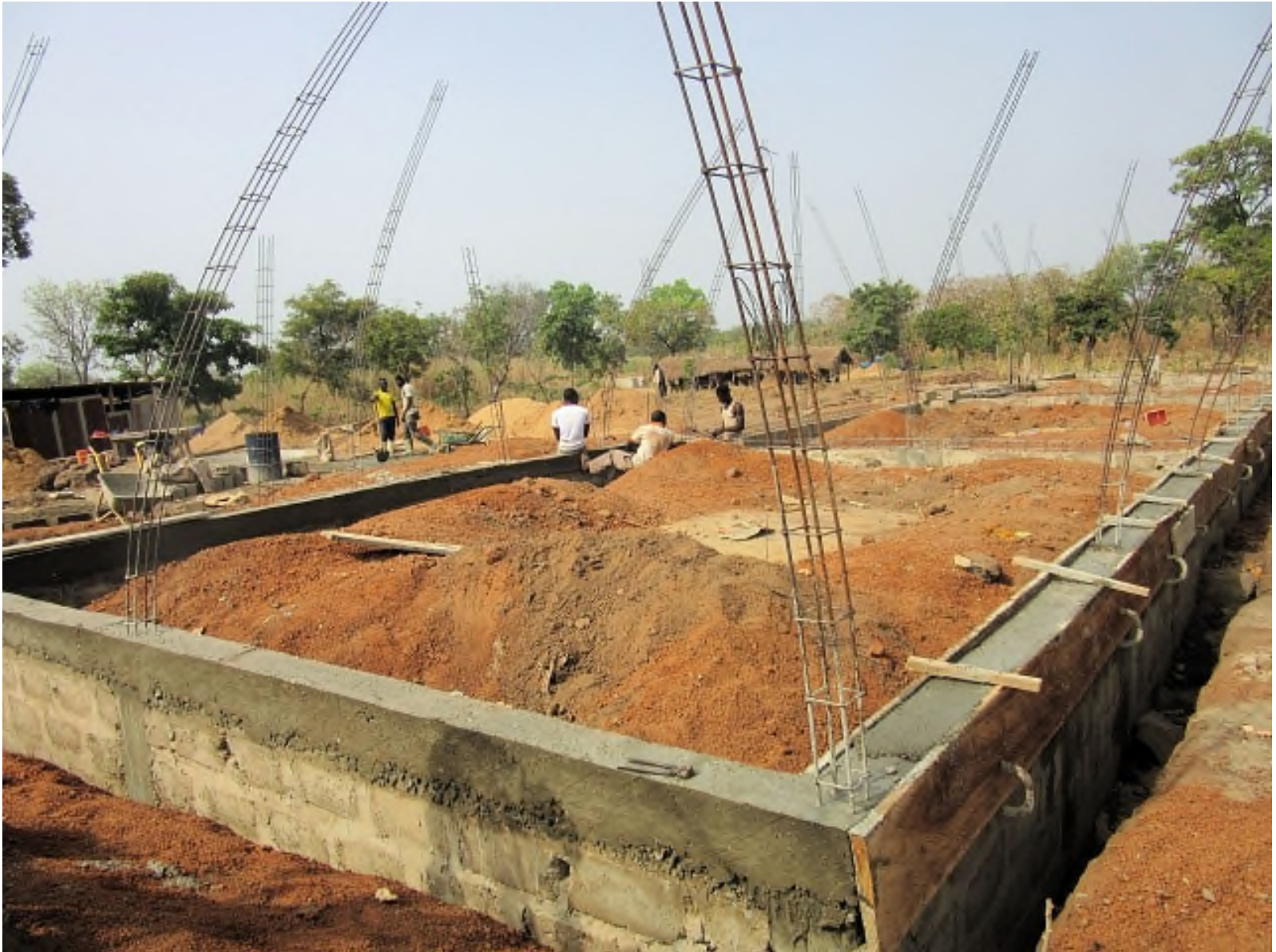
Die Fundamente sind fast fertig – im Hintergrund die alte Schule
