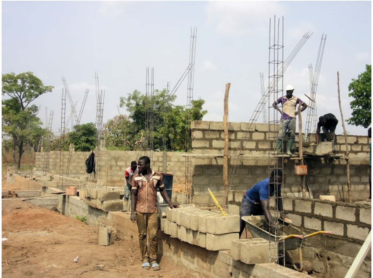
Die Mauern werden hochgezogen – einfach Gerüste
